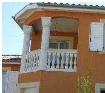
Type de balustres interdites
