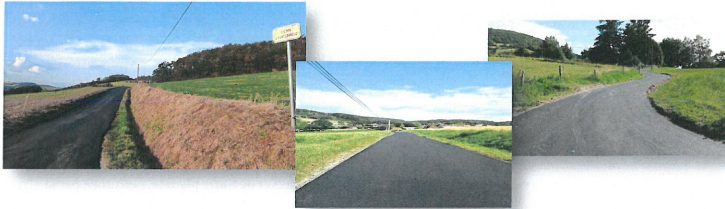
Travaux de voirie : « Fontgarnoud » et « le Martin »
